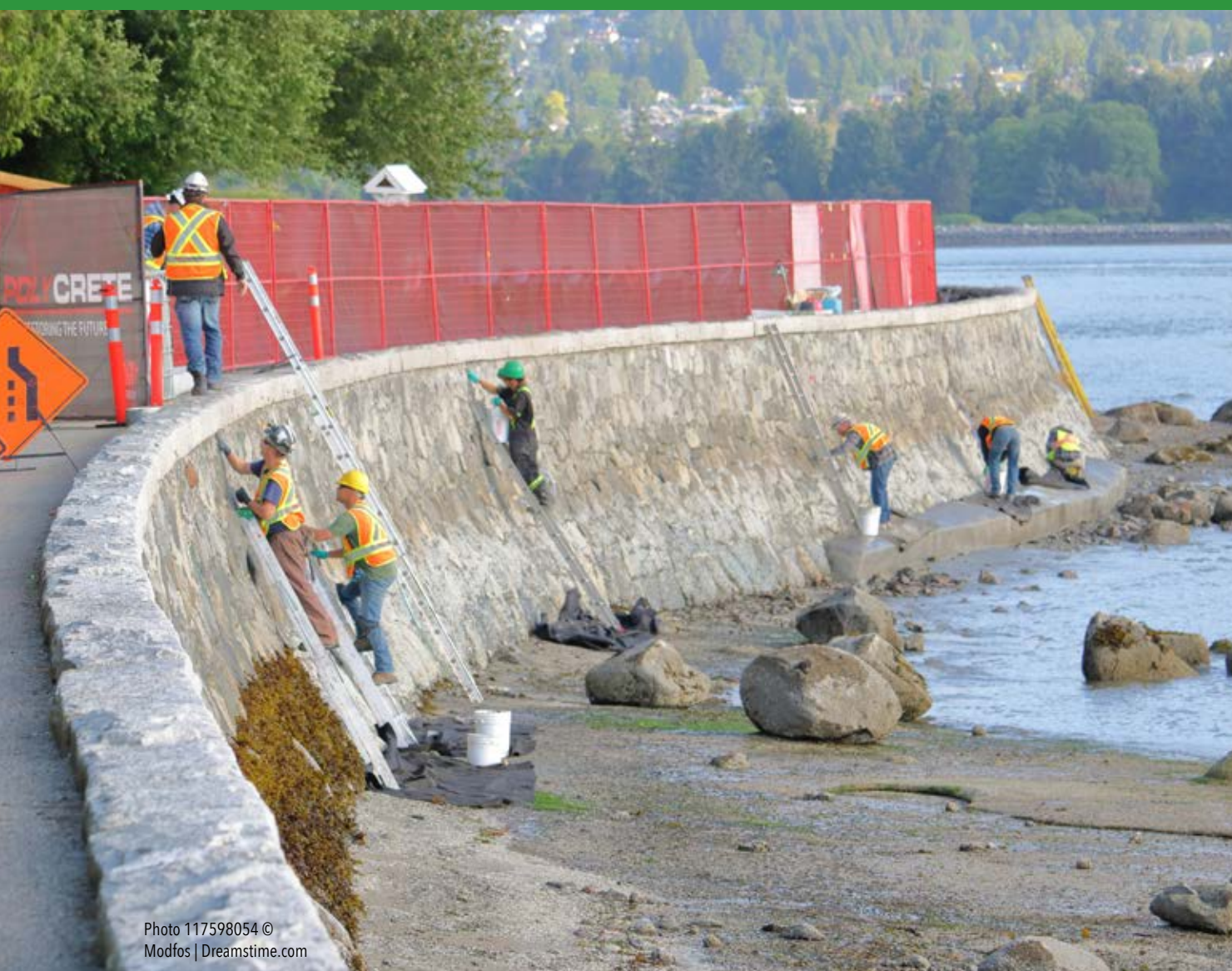
Réparation du mur de protection au parc Stanley, mai 2018
