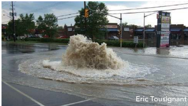
Égout pluvial surchargé sur le boulevard St-Joseph à Orléans, à Ottawa (2006).
